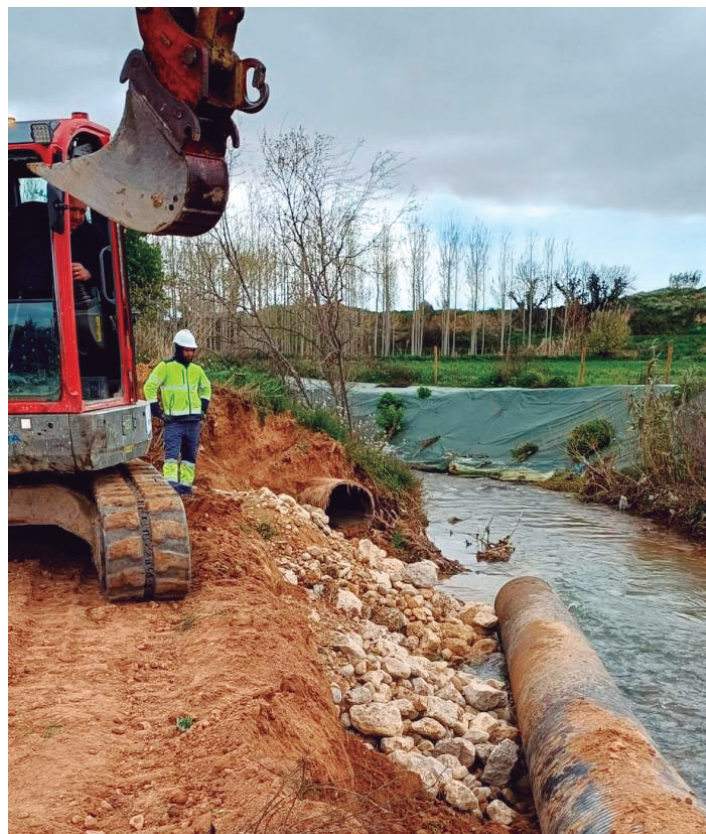
Trabajos de reparación realizados.
