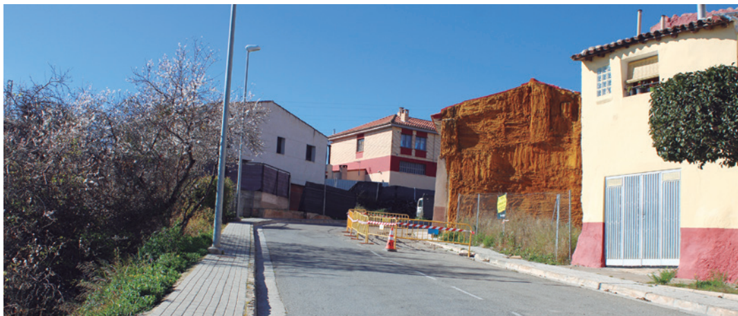
Los trabajos renovarán esta conocida vía.
