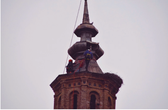
Los operarios durante la intervención. (CARLOS REMÍREZ)
