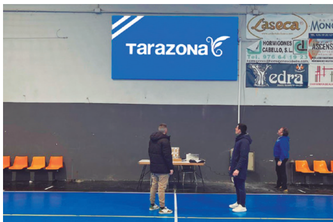
Revisando la instalación del nuevo equipo.
