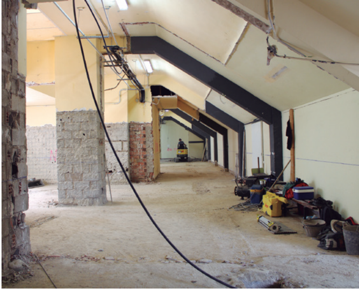
Así avanzan los trabajos en la zona de vestuarios.
