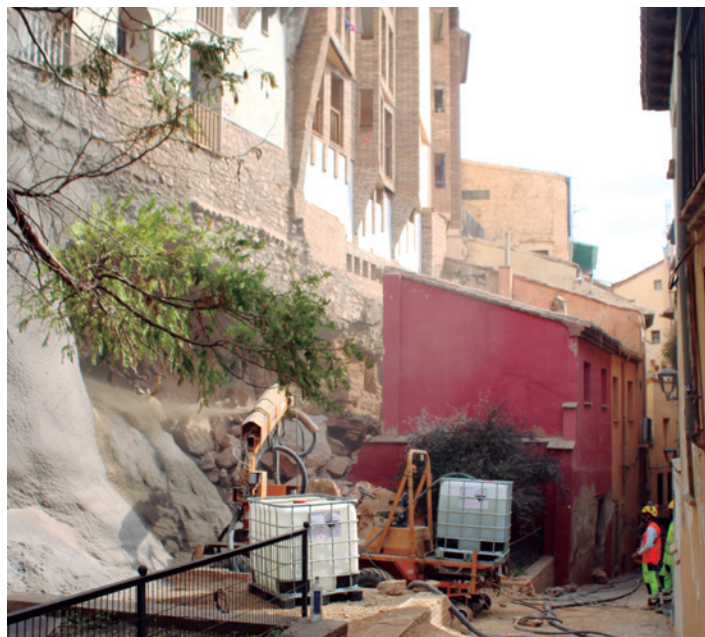
Imagen de los trabajos el día 13 de agosto.
