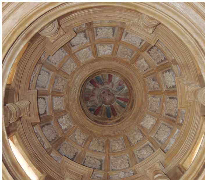
Aspecto de la cúpula durante su restauración.
