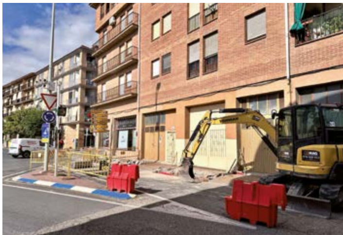
Trabajos junto a la Cuesta de la Rudiana.
