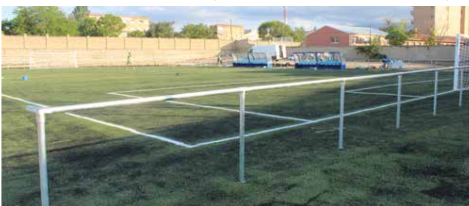
Últimos retoques al campo con el pintado de las líneas.
