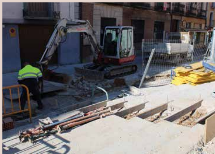
Los trabajos estarán finalizados en el mes de febrero.
