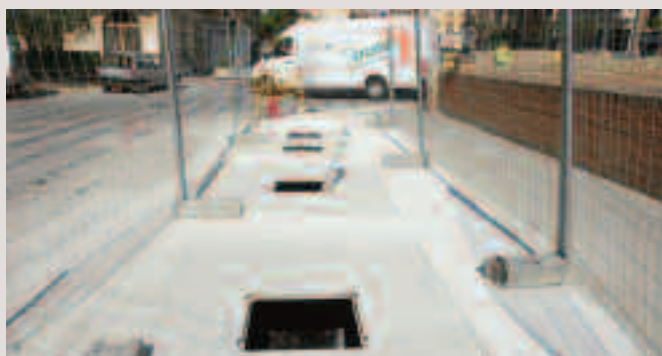
Se volverá a actuar en el soterramiento de contenedores.
